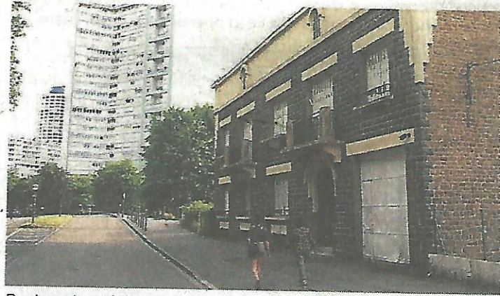
Boulevard maréchal de Lattre de Tassigny, un immeuble de 60 m de hauteur. Des habitants s'inquiètent.
