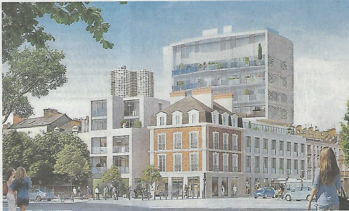
Le nouvel immeuble Inside, au cœur du centre-ville de Rennes.
