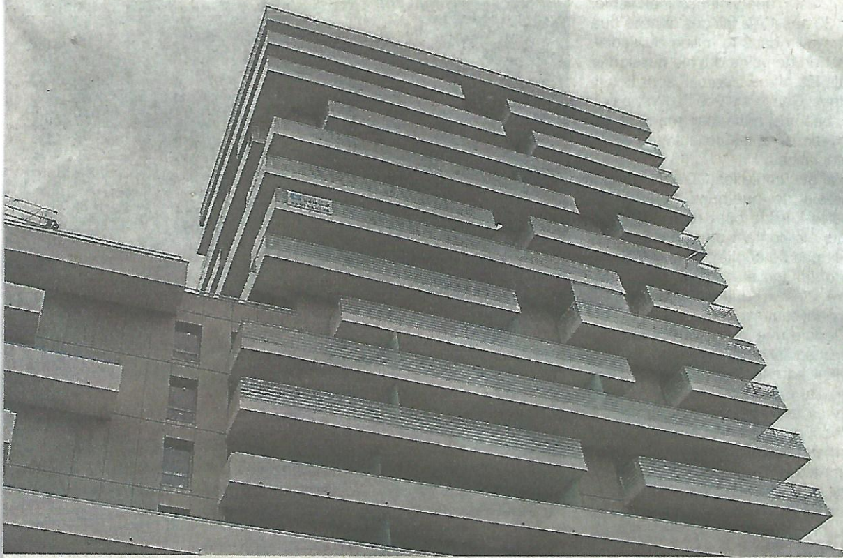
é construit avec des fondations sur pieux, en raison de la nature du terrain.
