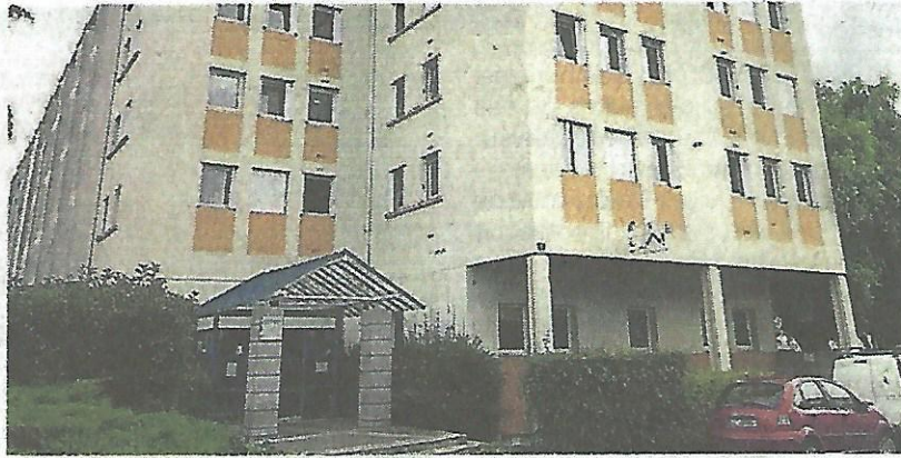
L'immeuble actuel, un Foyer de jeunes travailleurs, construit dans les années 1970, n'est plus adapté aux attentes des locataires. | CRÉDIT PHOTO : ARCHIVES OUEST-FRANCE
