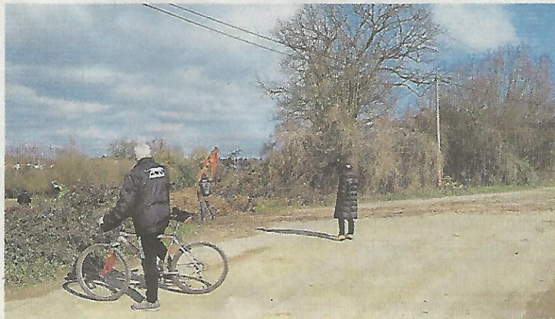
Riverains et promeneurs découvrent, depuis quelques jours, l'avancement des travaux
