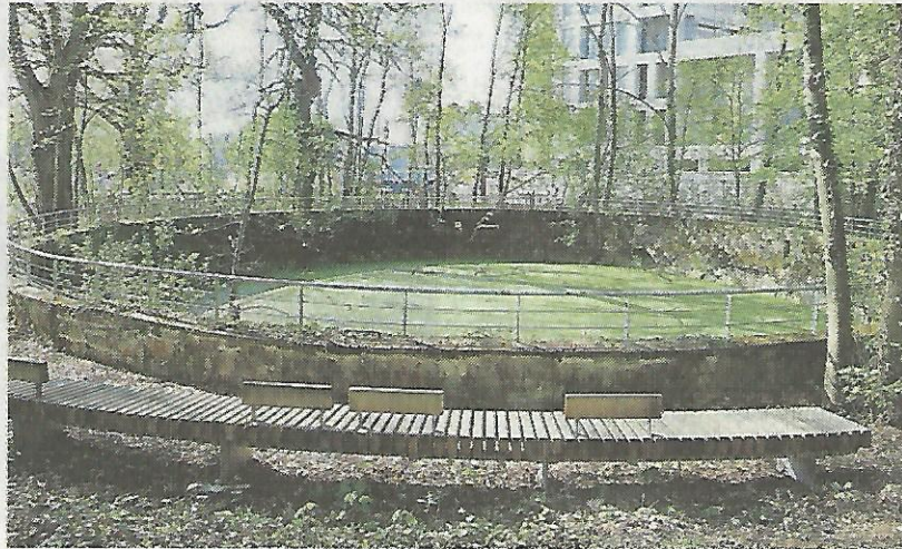
Un bassin préservé et utilisé comme réserve incendie, non loin de la future station de métro.
